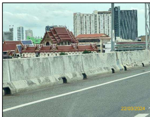
รูปที่ 2-14 กำแพงที่มีความแข็งแรงและมีความสูงเพื่อป้องกันการเกิดอุบัติเหตุบริเวณศาสนสถาน
